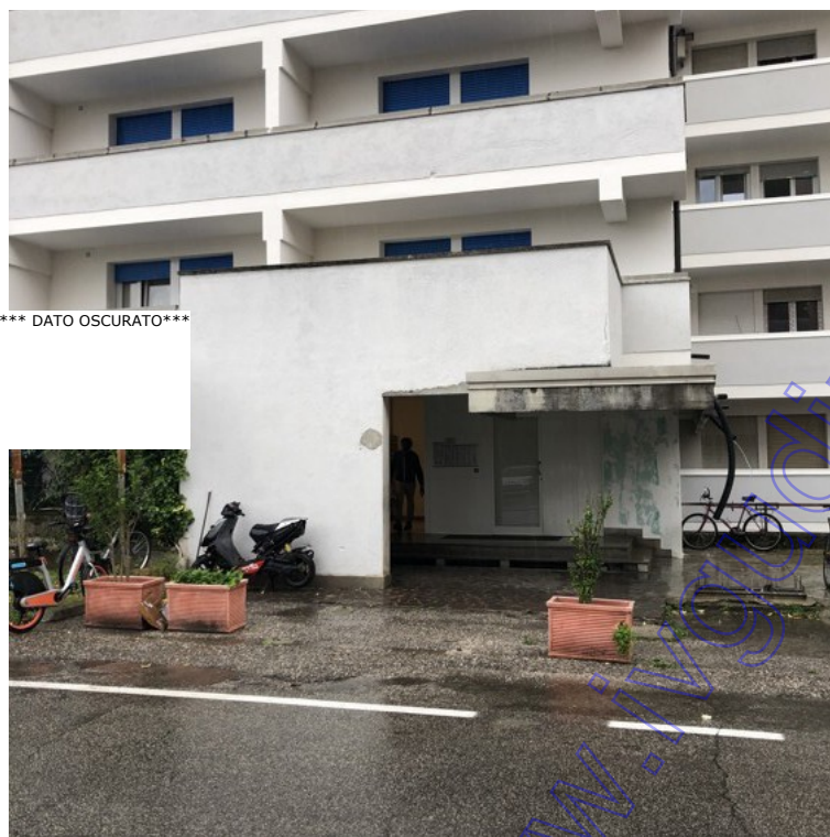
Fotografia A.5 - Ingresso condominio
