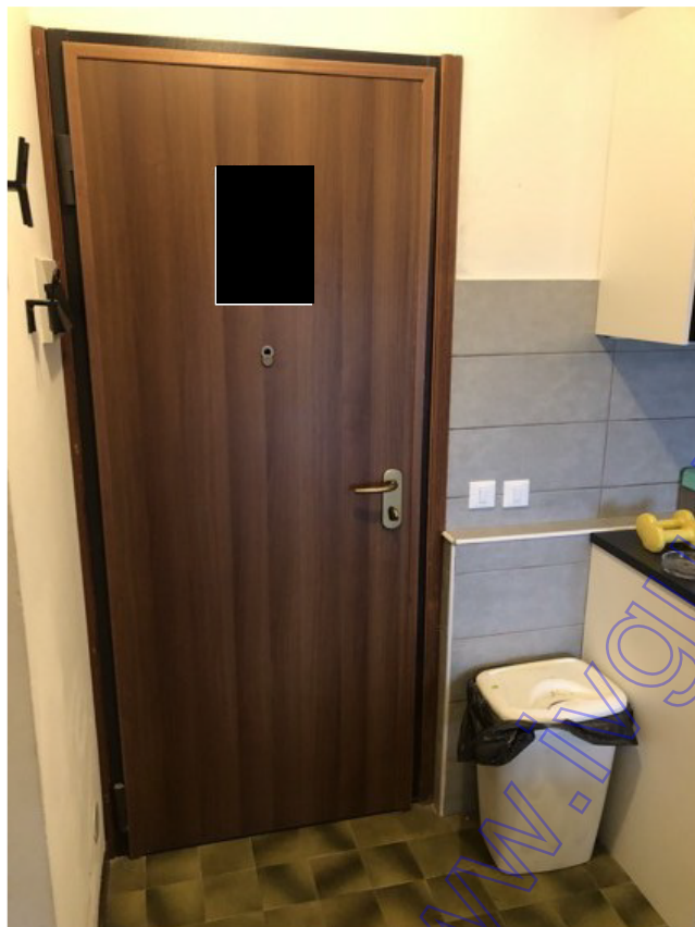
Fotografia A.9 - Porta ingresso unità
