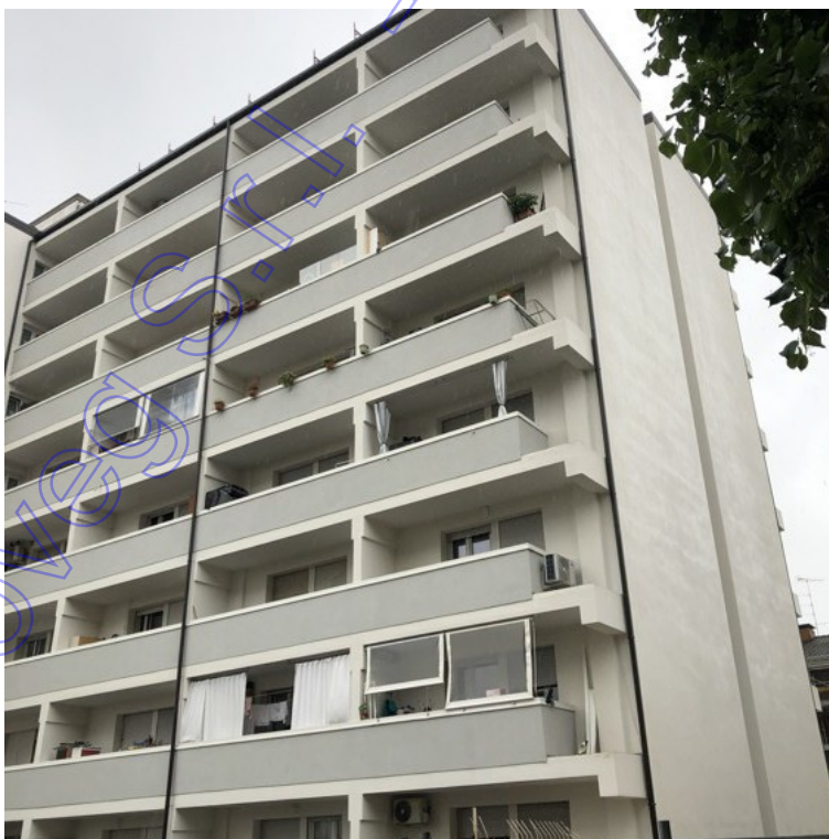
Fotografia A.4 - Prospetto Nord
